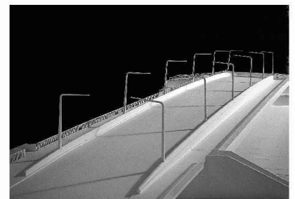
Die Langensandbrücke führt bei der Einfahrt zum Bahnhof Luzern über das Gleisfeld. Die Fahrbahn für den Strassenverkehr folgt der Wölbung der Brückenträger, die seitlichen Fusswege dagegen sind fast horizontal und kragen seitlich aus (Weiterbearbeitung: Gebr. Brun AG, Guscetti & Tournier, PlüssMeyerPartner, Brauen & Wälchli)
