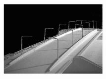
Die Langensandbrücke führt bei der Einfahrt zum Bahnhof Luzern über das Gleisfeld. Die Fahrbahn für den Strassenverkehr folgt der Wölbung der Brückenträger, die seitlichen Fusswege dagegen sind fast horizontal und kragen seitlich aus (Weiterbearbeitung: Gebr. Brun AG, Guscetti & Tournier, PlüssMeyerPartner, Brauen & Wälchli)
