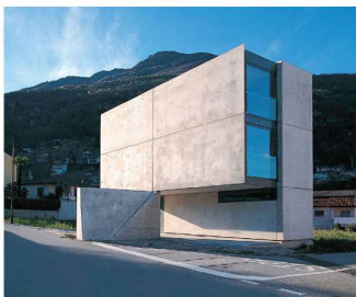
Guidotti &amp; Guidotti, Casa Grossi, Monte Carasso (Bild: Filippo Simonetti)
