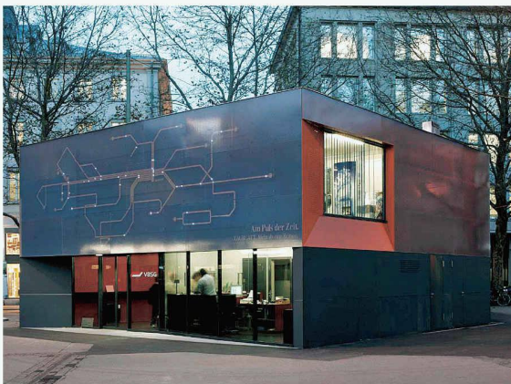
Pavillon der Verkehrsbetriebe am Bahnhofplatz St. Gallen. Peter Lüchinger, Architekt, St. Gallen
