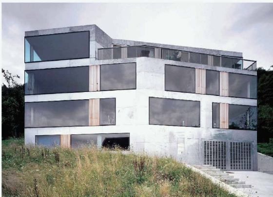
Mehrfamilienhaus in Zürich: Holzelemente, Betonkern, Blechfassade. Andreas Fuhrmann / Gabrielle Hächler, Architekten, Zürich
