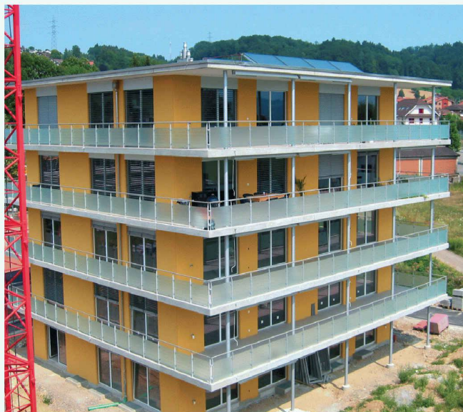
Zellfeldpark - Schenkon am Sempachersee – zukunftsweisende Wohn- und Arbeitsimmobilie, 2 x 6 Mehrfamilienhäuser mit Tiefgarage, Thermowände, Elementdecken –
