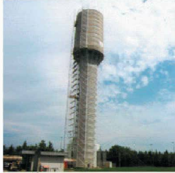
Behälter- und Bäderbau
