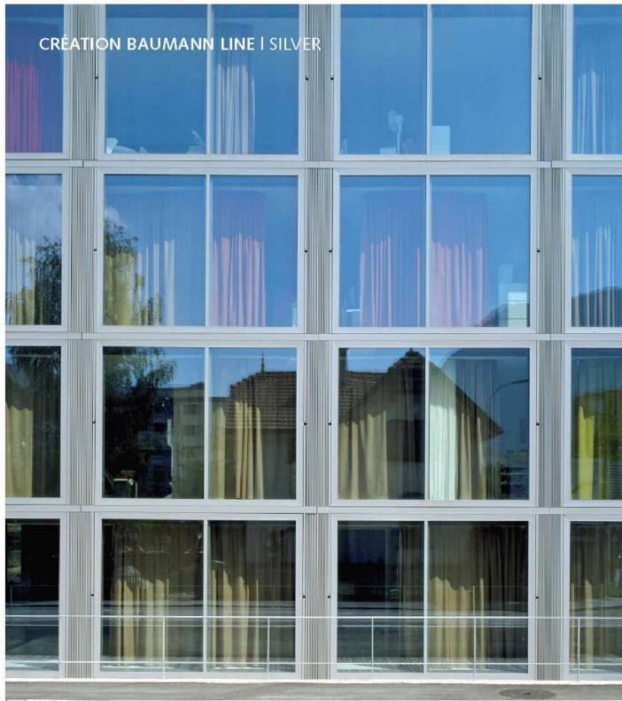
Die Silver-Kollektion mit ihrer dünnen Aluminiumschicht auf der Rückseite besticht durch einmaligen Sicht-, Blend-, Wärme- und UV-Schutz. Der ÖKK-Hauptsitz von Bearth+Deplazes kehrt Innen nach Aussen und bringt so Farbe auf den Bahnhofplatz von Landquart.
