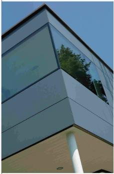
Durch die Bündigkeit von Flächen und Fugen scheinen die Fenster des Erkers mit der Fassade zu verschmelzen.
