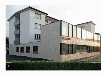
Raiffeisenbank beherbergen, mit ihrer Verkleidung aus vertikal geschichteten, vor- und zurückspringenden Jurakalkriemen vom Bestand ab. Die Materialisierung leitet sich aus dem ursprünglich in der Sockelzone verwendeten Naturstein ab, der sich unter einer Farbschicht verbarg.
