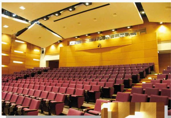
Solo® Paneele erfüllen alle akustischen und optischen Anforderungen an eine fugenlose Verkleidung. Längsseits mit Nut und Kamm versehen, was eine einfache und schnelle Montage ermöglicht.
