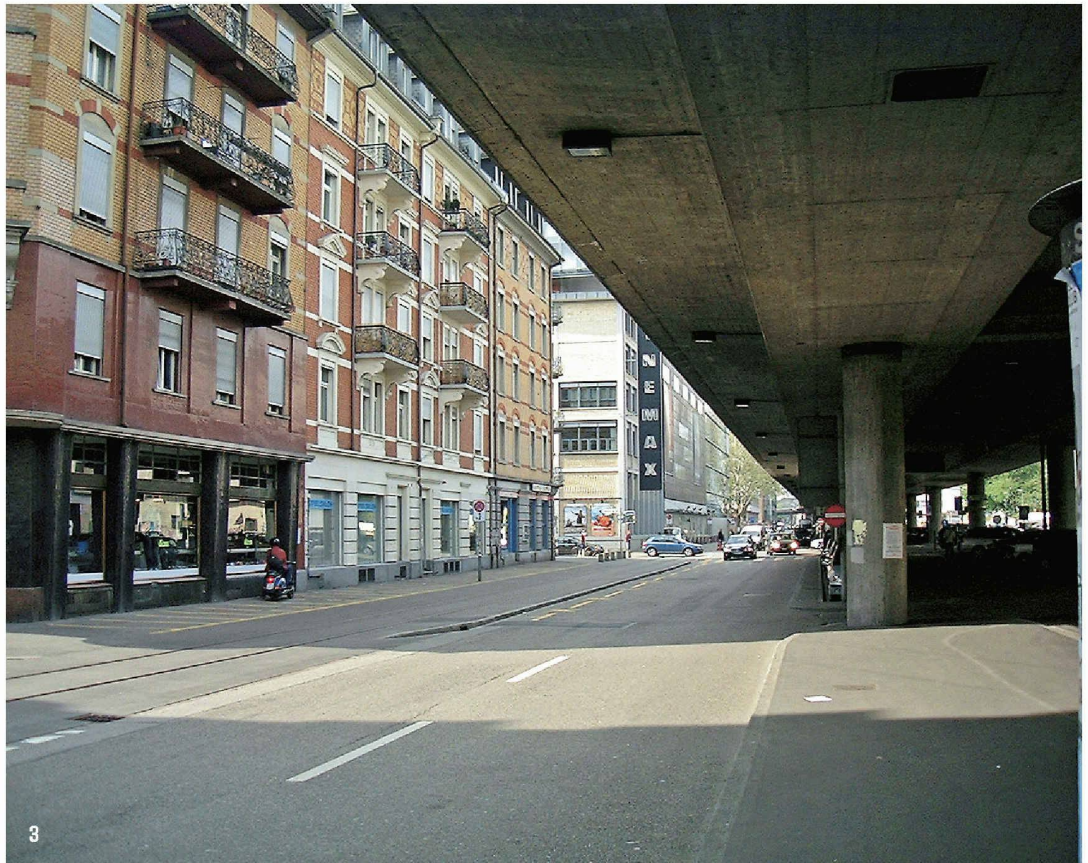
3 Situation zur Schallfelduntersuchung für eine projektierte, unter das Brückendach zu liegende Tramlinie
