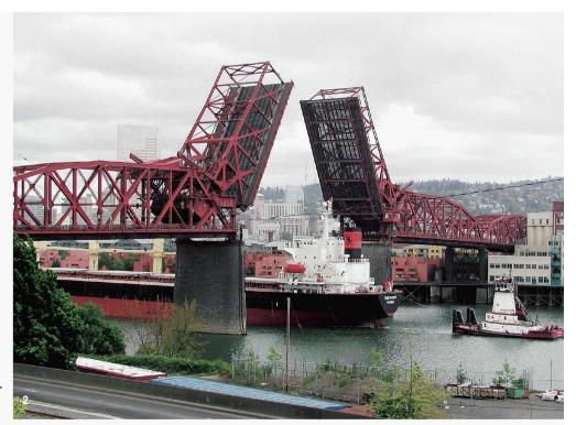
Bei der Stahlbrücke Broadway in Portland, USA, wurde 2005 der Stahlrost der Fahrbahn durch GFK-Platten ersetzt. Damit konnte eine indirekte Nutzlasterhöhung erreicht werden (Bild: Martin Marietta Composites, USA)
