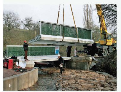
Deutschlands erste GFK-Strassenbrücke im sächsischen Klipphausen. Für die neuartige Brückenkonstruktion sollen die Vorteile des modernen Verbundmaterials (GFK-Asset-Profile) genutzt werden (Bild: Fiberline Composites, Dänemark).
