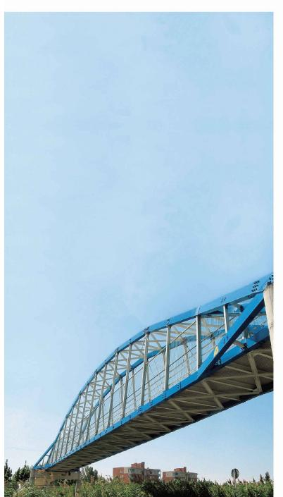
Die glasfaserverstärkte Geh- und Radwegbrücke bei Lleida in Spanien ist als Bogenbrücke konstruiert und hat eine Spannweite von 38 m (Bogenträger um 10° nach innen geneigt). Sie ist 3 m breit und als einfacher Balken gelagert. Diese Überbrückung einer Hochgeschwindigkeitsbahnstrecke und Strasse ist mit dem internationalen «Footbridge Award 2005» ausgezeichnet worden (Bild: Fiberline Composites, Dänemark)
