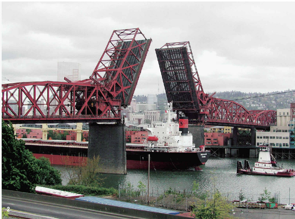
2 Bei der Stahlbrücke Broadway in Portland, USA, wurde 2005 der Stahlrost der Fahrbahn durch GFK-Platten ersetzt. Damit konnte eine indirekte Nutzlasterhöhung erreicht werden (Bild: Martin Marietta Composites, USA)
