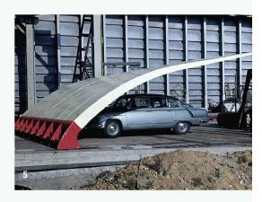
chung grosser Flächen, wie beispielsweise für den Eingang der Expo 1964 in Lausanne von Heinz Hossdorf oder für die Tankstelle Thun von Heinz Isler. Für diese riesige Sandwichkonstruktion von 14.50 × 22 m entwickelte der Ingenieur eine eigene Herstellungstechnik und ein Zelt für die Produktion unter Werkstattbedingungen.
