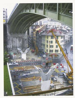
Gegensatz zu den üblichen Ausführungen ist das Jetgewölbe zylindrisch und wird in einem Zug auf einer Länge von 21 m vor Beginn der Ausbrucharbeiten erstellt. Es besteht aus mit Zementschlämme stabilisierten Metallrohren und aus mit Reaktionsharz stabilisierten selbstbohrenden Bolzen.
