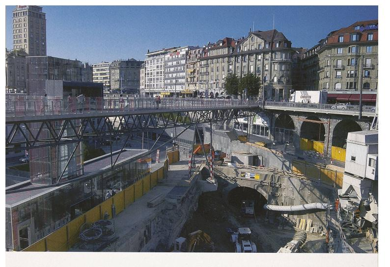
Die Mikropfähle sind – je nach ihrer Position und ihrem Beitrag zum vertikalen und horizontalen Gleichgewicht der Brücke – in 13 separat überprüfbaren Gruppen zusammengefasst.
