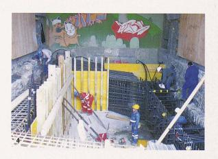
es in den Werkplänen des bestehenden Bauwerks angegeben war, was eine Verringerung der statischen Höhe der Betonträger erforderlich machte. Diese Reduktion wurde durch den Einbau von Vorspannkabeln kompensiert, um Unterfangungen zu vermeiden.
