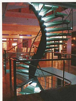
Edelstahl mit seiner fein geschliffenen Oberfläche, Glas in Form von Glas-Verbundsicherheitsstufen sowie eine Leuchtdioden-Stufenausleuchtung. Dank dem Glas erscheinen die unterschiedlichen Ebenen und Gebäudeteile offen. Die Leuchtdioden lassen die Treppe abends in einem faszinierenden Licht erstrahlen. Aktiviert werden sie über Lichtschranken und stufenweise Lauflichtsteuerung mittels Mikrocontroller-Elektronik. Der Einbau einer audio-akustischen Sensorik ist optional ebenfalls möglich.
