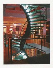
Edelstahl mit seiner fein geschliffenen Oberfläche, Glas in Form von Glas-Verbundsicherheitsstufen sowie eine Leuchtdioden-Stufenausleuchtung. Dank dem Glas erscheinen die unterschiedlichen Ebenen und Gebäudeteile offen. Die Leuchtdioden lassen die Treppe abends in einem faszinierenden Licht erstrahlen. Aktiviert werden sie über Lichtschranken und stufenweise Lauflichtsteuerung mittels Mikrocontroller-Elektronik. Der Einbau einer audio-akustischen Sensorik ist optional ebenfalls möglich.
