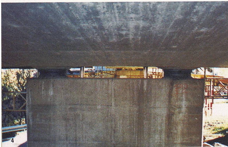
3 Einbau eines neuen Topfgleitlagers im talseitigen Widerlager WL1
