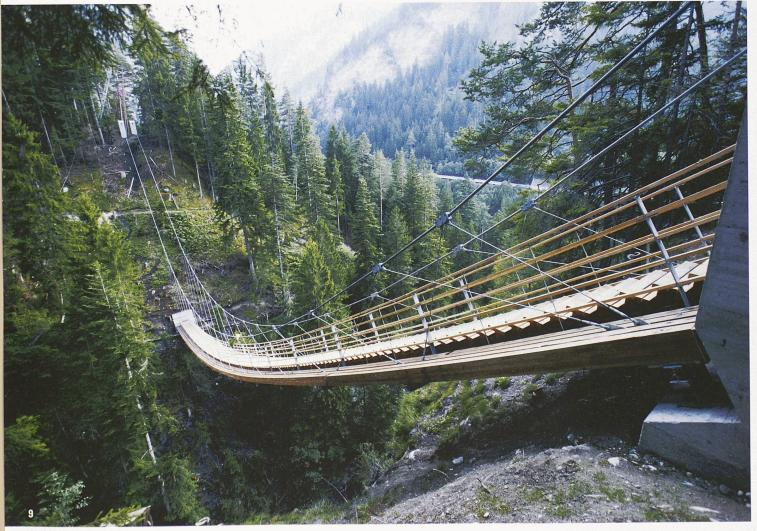
Beim zweiten Traversiner Steg entschieden sich die Ingenieure für eine Hängebrücke, genauer gesagt: für ein vorgespanntes Seilfachwerk, das in zwei vertikalen, parallelen Ebenen angeordnet ist. Das Spezielle dabei: Die beiden Hauptseilverankerungen liegen unterschiedlich hoch (Bild 1), und der Brückenweg führt vom tiefer gelegenen Auflager etwas abwärts zum gegenüberliegenden Hang. Zwischen Hauptseilen und Brückenweg sind diagonale Seile gespannt.
