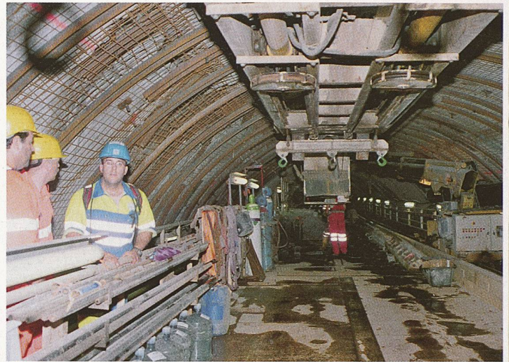
Die engen Verhältnisse und die langen Transportwege erfordern eine gut organisierte Logistik, damit der Vortrieb nicht behindert wird (Bilder: Schmid)
