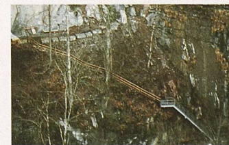
Balmburg-Ruine Rothenfluh und der neu erstellte ehemalige Zugangsweg (Bilder: ADB)
