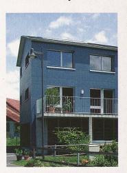
Nachhaltige Bauweise umfasst Werterhaltung, Wirtschaftlichkeit und den Einsatz langlebiger Baustoffe. Für das Minergie-P-Haus in Ruggell und das Niedrigenergiehaus in Triesenberg wurden Faserzementplatten als Wetterhaut für die Aussenwände verwendet. Diese bestehen aus stockwerkhohen Wandelementen aus Holz mit 60 cm Breite und 30 cm Dicke. Ein an den Wandelementen angebrachter Holzlattenrost dient als Unterkonstruktion für die vorgehängte, witterungsbeständige Fassadenbekleidung.
