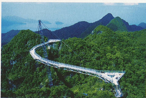
Prix Acier: Aussichtsbrücke in Malaysia. Lediglich ein Pylon trägt die 120 m spannende, geschwungene Brücke (Bild: SZS)
