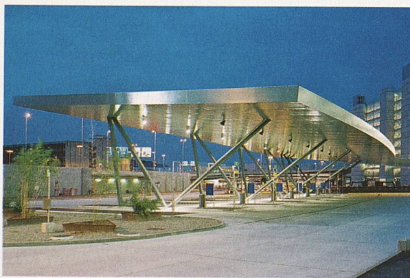
Prix Acier: Bushofüberdachung am Flughafen Zürich. Stahl und lichtdurchlässige Dachelemente aus Fiberglas (Bild: Ralph Bensberg)
