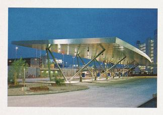
Prix Acier: Bushofüberdachung am Flughafen Zürich. Stahl und lichtdurchlässige Dachelemente aus Fiberglas (Bild: Ralph Bensberg)
