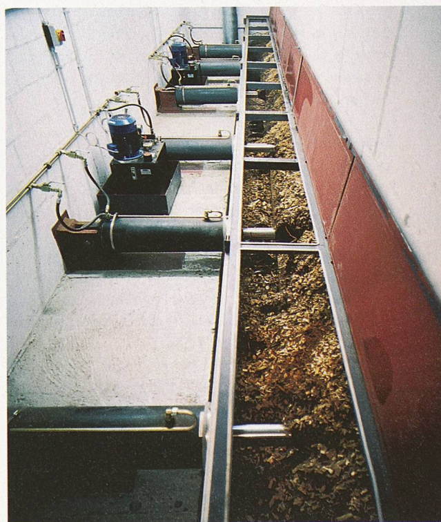
Schubstangen befördern die Schnitzel zur Sammelschnecke, von wo sie über eine geregelte Dosierschnecke direkt in den Feuerraum gelangen
