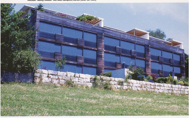
«Wegere» von Renggli ist eines von fünf Reiheneinfamilienhäusern in Nebikon. Die zweigeschossigen, in Holzbauweise erstellten Gebäude stehen unter einem durchgehenden Dach. Die konsequente passive Sonnennutzung wird durch eine starke Wärmedämmung ergänzt (Bild 3).
