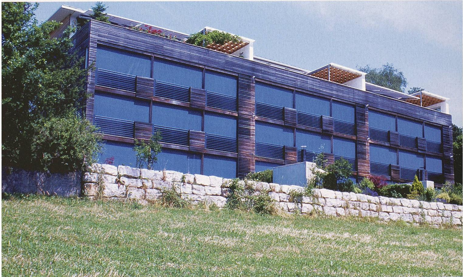
«Wegere» von Renggli ist eines von fünf Reiheneinfamilienhäusern in Nebikon. Die zweigeschossigen, in Holzbauweise erstellten Gebäude stehen unter einem durchgehenden Dach. Die konsequente passive Sonnenutzung wird durch eine starke Wärmedämmung ergänzt (Bild 3).
