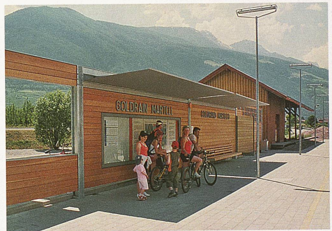
Alle Stationen sind mit freundlichen, modernen Warteunterständen aus Stahl und Holz ausgerüstet
