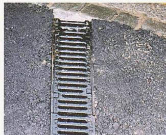
besteht aus Polymerbeton, einem äusserst dauerhaften und alterungsbeständigen Material. Aufgrund der monolithischen Bauweise verfügt der SK-Block über keine beweglichen Teile, erzeugt also keine Klappergeräusche und ist vandalismusicher. Die Rinne eignet sich bestens für den Einbau in von Vandalismus gefährdete Zonen wie Stadien, Innenbereiche
