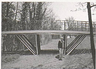
Schlanke Spannbandkonstruktion für den Aaresteg (1. Rang Aaresteg, Zulauf & Schmidlin / Schweingruber Zulauf / Conzett, Bronzini, Gartmann)
