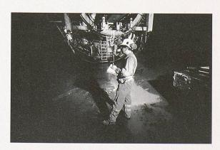
Ein Geologe nutzt einen Unterbruch des Tunnelvortriebs für mineralogische Aufnahmen im Sicherungsbereich hinter dem Bohrkopf der Tunnelbohrmaschine (TBM). Bei Stillstand der TBM ist ein etwa 15 m langer Felsabschnitt für die visuelle Inspektion und die Entnahme von Gesteinsproben zugänglich (Bilder: Stefan Ansermet)
