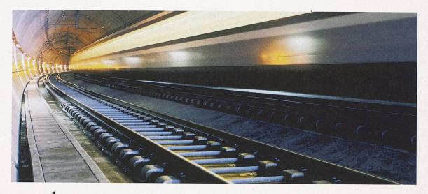
Feste Fahrbahn im Betrieb im Grauholztunnel (Bahn 2000; Bild: SBB)
