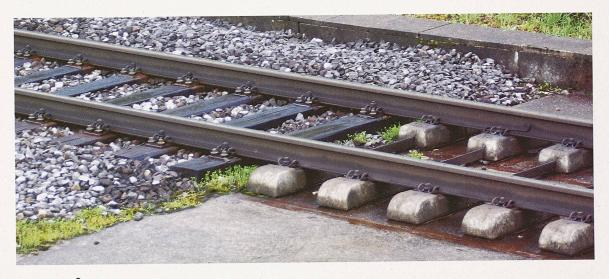
Zwei grundlegend verschiedene Systeme mit optimal abgestimmtem Verhalten: Übergang Schotteroberbau / Feste Fahrbahn in Zürich Stettbach (S-Bahn Zürich, seit 1989; Bild: Rolf Steinegger / SBB)
