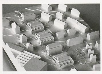
Geplant sind 3 breite und 2 schmale Baukörper (Modellbild). Oberirdische Parkierung und Umgang mit Niveausprung im Gelände (Schnitt). Umlaufende Terrasse im Attikageschoss (1. Rang, Gmür & Steib)
