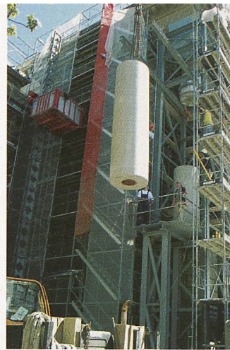
Gottfried Sempers Stadthaus. Letzte Phase der spektakulären Arbeiten: 13. bis 17. Juni (Bild: Johann Frei)
