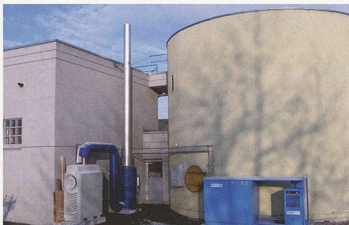
30-kW-Gasturbine der Abwasserreinigungsanlage Frick (Bild: eam)
