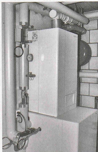
Unter den Öl-Brennwertkesseln gibt es auch Wandgeräte.
