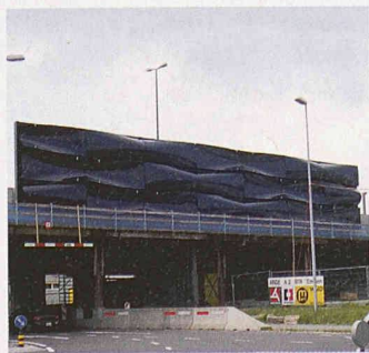
Verkleidete Lärmschutzwände bei Emmen (Bild: VIF, Kt. Luzern)
