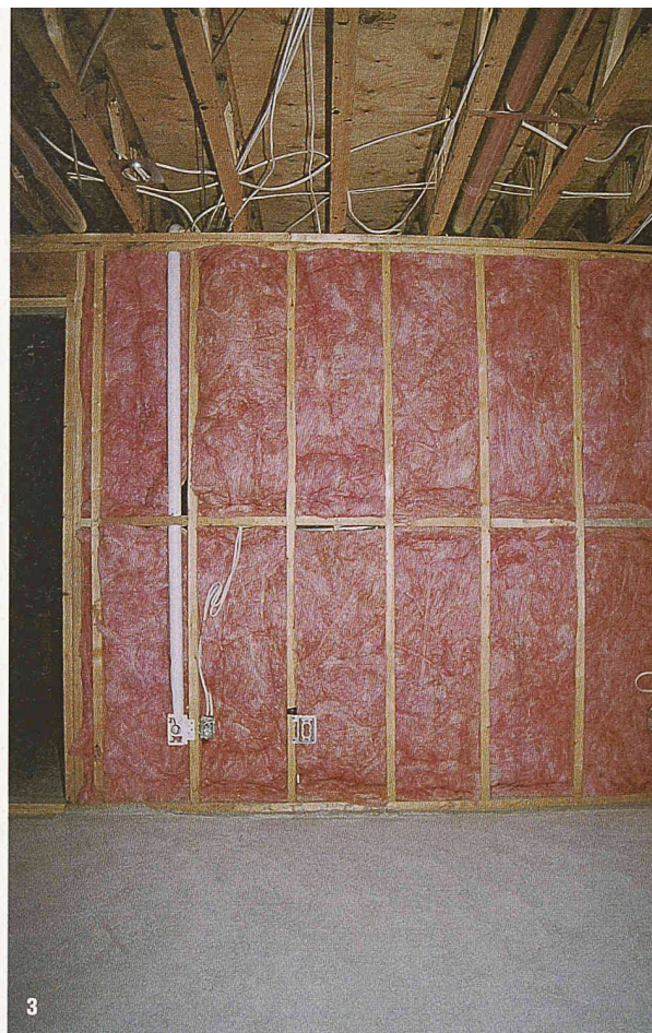
Kellerwand eines Einfamilienhauses. Latten mit dem Standardquerschnitt 38/89 mm bilden das Gerüst. Dazwischen liegt hier (gegen die unbeheizte Garage) Glaswolle als Wärmedämmung.
