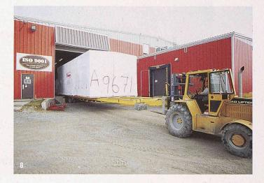
Ein Viertel eines Einfamilienhauses verlässt die Produktionshalle. Das etwas mehr als 3 m breite und rund 10 m lange Modul ist komplett ausgerüstet und wird auf der Baustelle mit drei weiteren Elementen zum fertigen Haus zusammengefügt. Die Dachträger sind für den Transport abklappbar konstruiert
