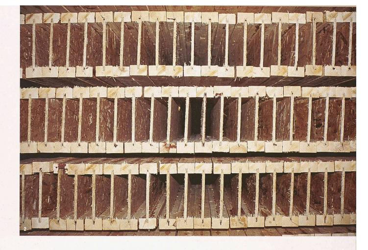
Die nichttragende Leichtbauweise der Zwischenwände vereinfacht den Umbau dieser 60-jährigen Überbauung in Montreal. Die relativ geringen Ansprüche an den Schallschutz erlauben die anschliessende Beplankung lediglich mit Gipskartonplatten
