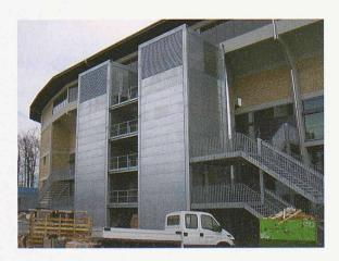
Die Lüftungsaggregate stecken hochkant in 19 m hohen, aussen angedockten Türmen (Bild: Giorgio Hoch)
