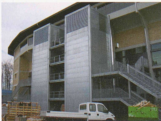
Die Lüftungsaggregate stecken hochkant in 19 m hohen, aussen andockten Türmen (Bild: Giorgio Hoch)
