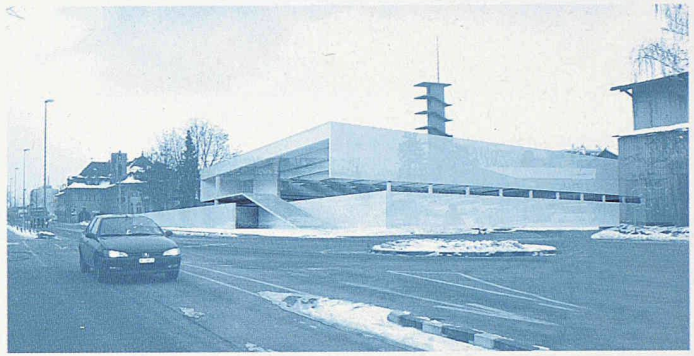
Die Eingangssituation mit der gedeckten Aussentreppe (1. Rang, GXM Architekten)
