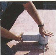
Frontteil auf Schalung aufnageln, Gehäuse aufstecken...
