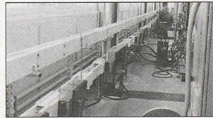
**LANZ HE-Stromschiene zur sicheren Stromübertragung und -Verteilung IP 68 Giessharzvergossen 400 A – 6000 A**
