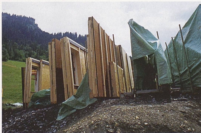
Aus diesen vorgefertigten Elementen wurde das Willimann-Haus (1998–1999) von Bearth & Deplazes in Sevgein GR gebaut (Bilder: www.awonline.net)
