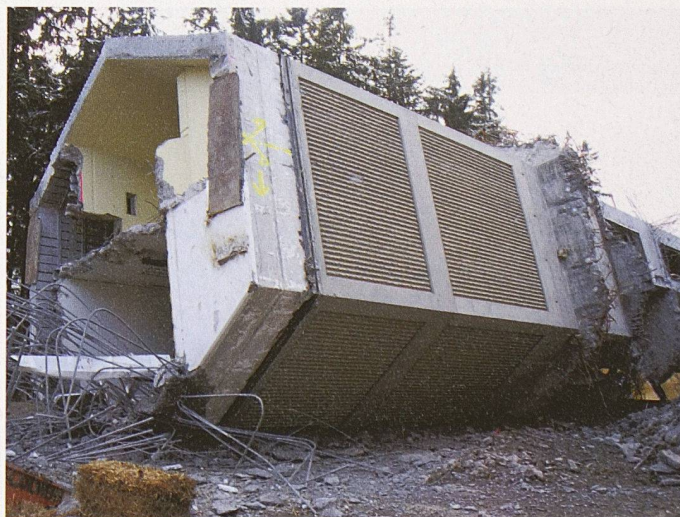
8 Unten die Sprengenebene im Restquerschnitt (Bild: Nicolas Contesse)
