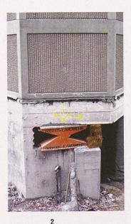
Eines der 2 Stahlkippgelenke im Turmfuss, links Beton-Restquerschnitt
