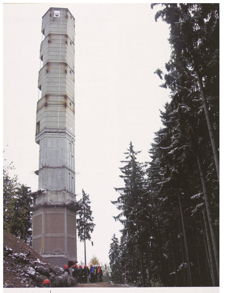
Der für die Fällung vorbereitete, auf den hexagonalen Kern reduzierte Turm ohne die ca. 15 m hohe Antennennadel, vier Antennengalerien und Verkleidung des unteren Drittels. Das eingeschossige Betriebsgebäude am Turmfuss ist vollständig abgebrochen (Bilder: Nicolas Contesse)
