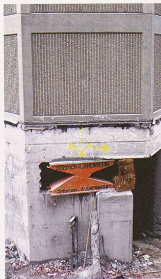
Eines der 2 Stahlkippgelenke im Turmfuss, links Beton-Restquerschnitt
