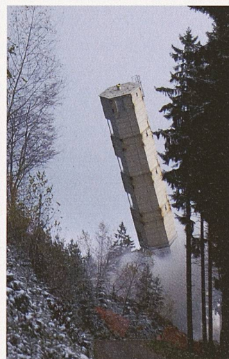
Fallsprengung des Richtfunksendeturms Höhrnonen am 9. November 2004 (Bilder: Erhard Hofer)
