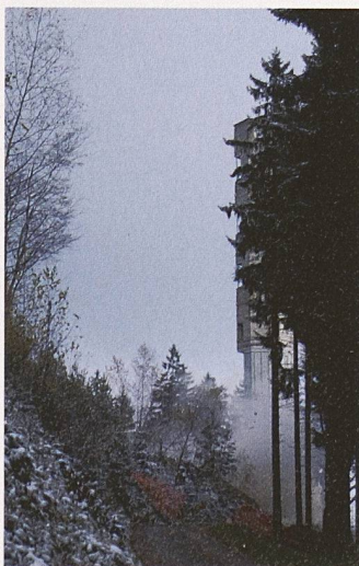
Fallsprengung des Richtfunksendeturms Höhrnonen am 9. November 2004 (Bilder: Erhard Hofer)
