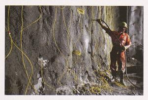
a Einpumpen der Matrix an der mit Spritzbeton gesicherten Ortsbrust der Multifunktionsstelle (MFS) Faido
