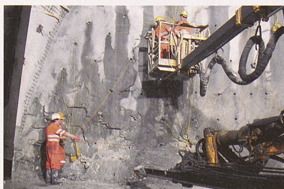
Ortsbrust der MFS Faido mit gebündelten Sprengschnüren kurz vor der Sprengung
