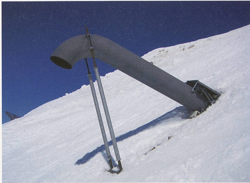
Ortsfeste Lawinensprenganlage: Sprengmast Wyssen auf der Engstligenalp bei Adelboden. Die Ladung wird an einem Seil vom Magazinkasten abgeworfen und detoniert über der Schneedecke (Bild: Wyssen Seilbahnen)
