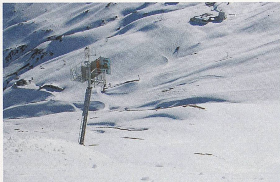
Ortsfeste Lawinensprenganlage: Sprenganlage Inauen-Schätti auf Davos Parsenn. Die offene Türe ist bereit zum ferngesteuerten Auswurf der Ladung
