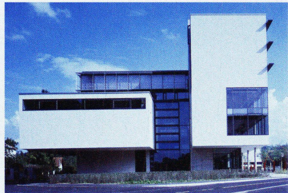
Der SIA hielt die 2. Delegiertenversammlung 2005 im neuen Erweiterungsbau der Universität Freiburg ab. Architektur: Büro B, Bern (Bild: Büro B/Jürg Maeschi)
