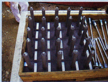
Anlieferung der ZDE-OV-GV-0-30-Elemente
