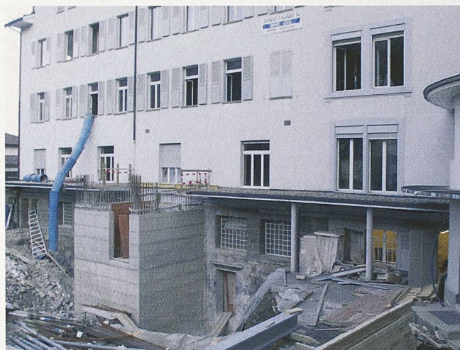
Ein angebauter Liftkern aus Stahlbeton verbessert die Erdbebensicherheit an einem Schulhaus in Monthey VS (Bild: Wenk)
