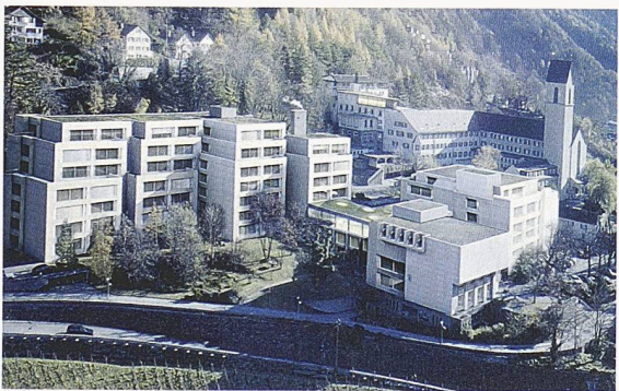
Mit grossflächigen Betonplatten eingekleidet (HRS / Maurus Frei / Roger Boltshauser)
