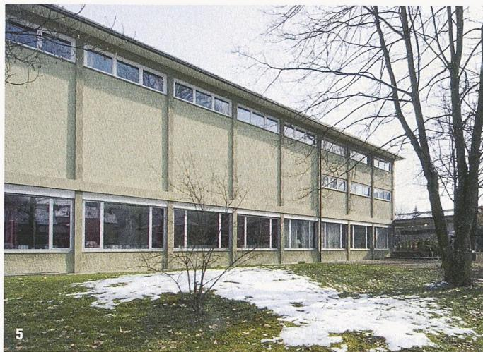
granität gestärkt wurden. Die Farbigkeit wurde unabhängig von der Originalfarbe Grau-ocker und dem hellgrauen Innenanstrich gewählt. Um die Stützen nicht vom Rest des insgesamt heller gestrichenen Gebäudes zu isolieren, wurden die Raumabschlüsse der beiden oberen Geschosse in derselben Farbe gestrichen.
