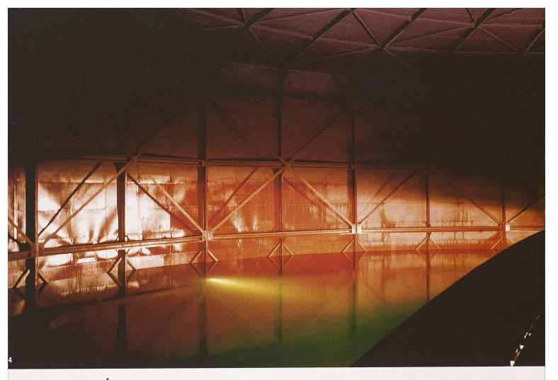
Der hier sichtbare, innerste Teil des Teleskops, die Glocke, steht in Ruheposition neu auf Stützen. Das Wasserbecken ist 8 m tief
