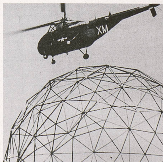
3 Bau der geodätischen Kugel in St. Louis, 1959
