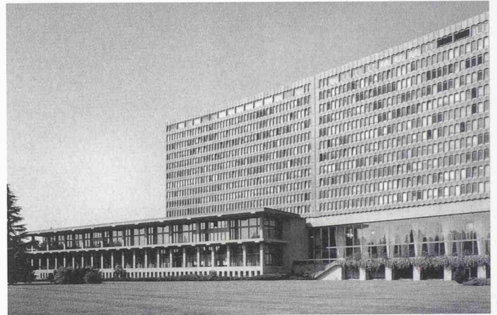
Bureau International du Travail in Genf (1965–75), Alberto Camenzind mit Eugène Beaudoin und Pier Luigi Nervi (Bilder: gta)
